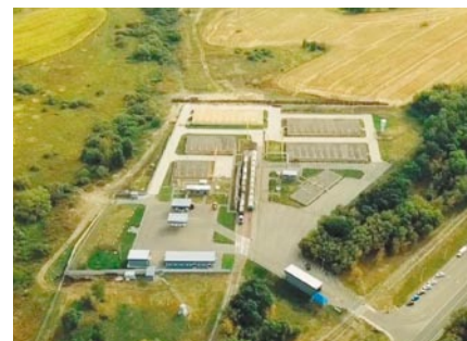
В конце 2018 года «Интрансгаз» завершил возведение собственной газонаполнительной станции
